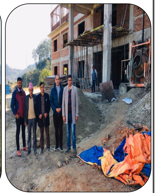
मालिका प्रशासकिय भवन
