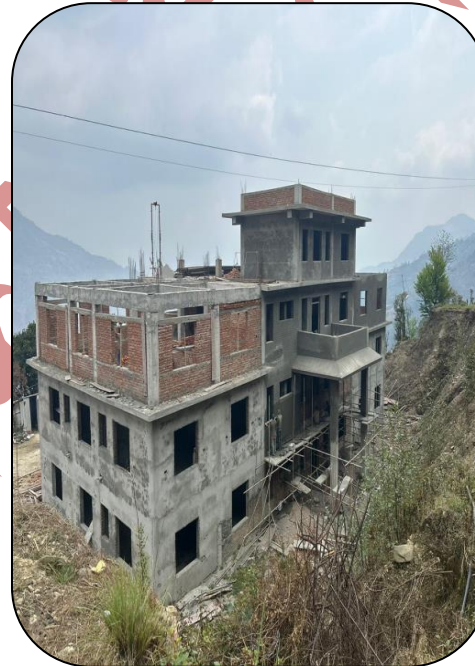
मालिका प्रशासकिय भवन
